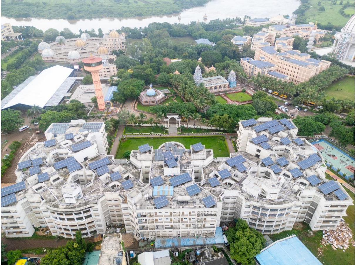
Solar Panel Installed on the Hostels of the MIT ADT
